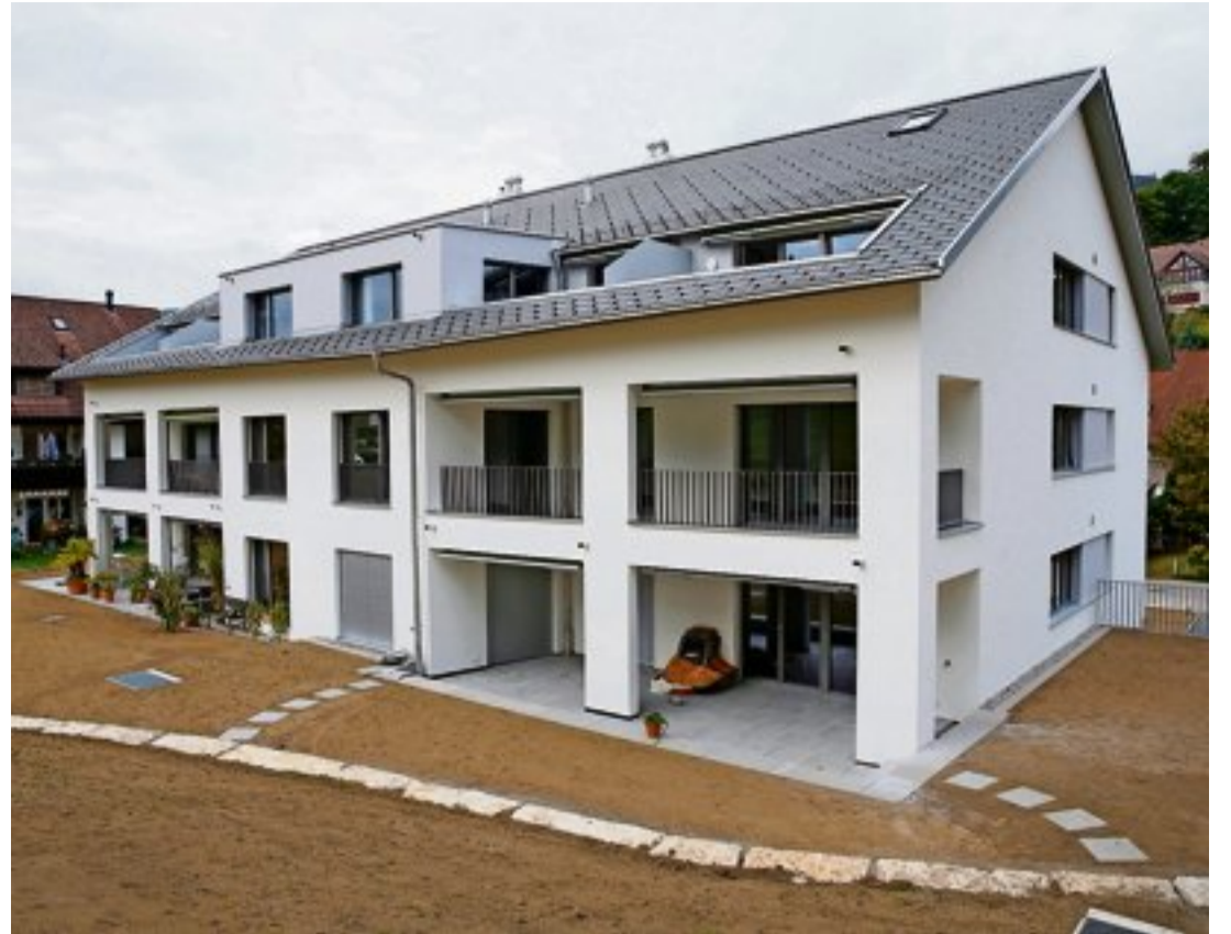
Die zwölf Wohnungen kosten zwischen 1300 und 1800 Franken monatlich.
